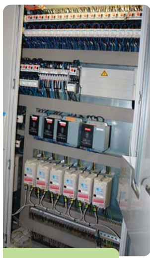
Bild 5: Bei der Produktion von Biogas ist eine Vielzahl an Frequenzumrichtern im Dauereinsatz. Ein robustes Ethernet-Netzwerk wie Varan ermöglicht eine hohe Verfügbarkeit.
