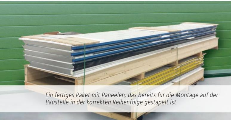
Ein fertiges Paket mit Paneelen, das bereits für die Montage auf der Baustelle in der korrekten Reihenfolge gestapelt ist
